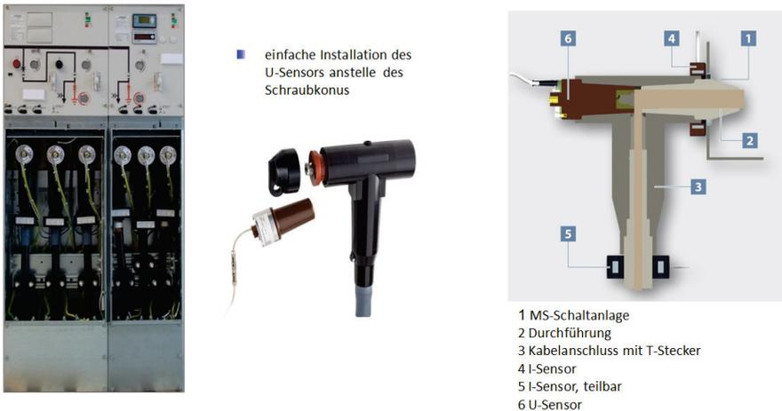
Abbildung 4: Anbau der U/I-Sensoren am Kabelabgang der MS-Schaltanlage
